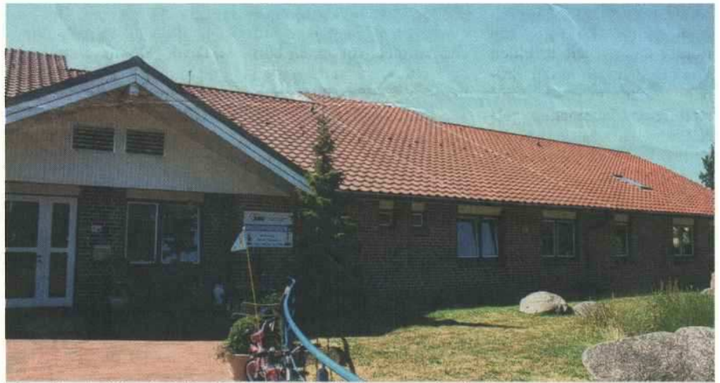
Ein optimaler Standort: Das Dach des AWO-Kinder Gartens im Merlinweg.
